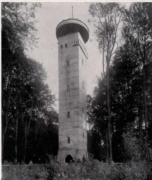
Das obenstehende Bild zeigt den Schwarzenbergturm im Saarbrücker Stadtwald, den die Fa. HEINRICH LENHARD G. m. b. H., Saarbrücken, 1931 im Auftrage des Verschönerungsvereins Saarbrücken errichtet hat. Der 46 m hohe Turm aus Eisenbeton wurde innerhalb 6 Wochen mit Hilfe einer modernen Gießmastanlage gegossen; besondere Beachtung verdient der freikragende Pilz des Turmtellers.
