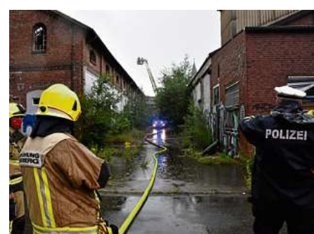
Von der Drehleiter aus haben Feuerwehrleute das Dach der alten Fabrikhalle gut im Blick. FOTO: A. SULANKE
